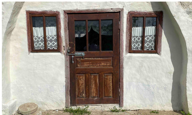
Foto 3. Fațada unui bordei din Rogojeni, r-nul Șoldănești, cu o ușă centrală și două ferestre mici. Pereții din piatră sunt finisați cu lut amestecat cu paie. 22 aprilie 2025.
